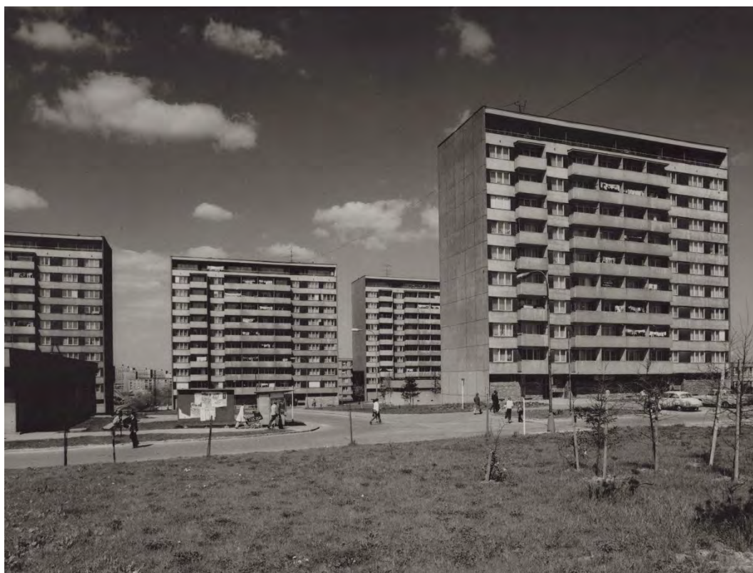
8/Výškové dvojdomy ve Výškovicích (1980).
