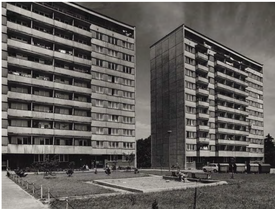
7/Výškové dvojdomy ve Výškovicích (1979).
